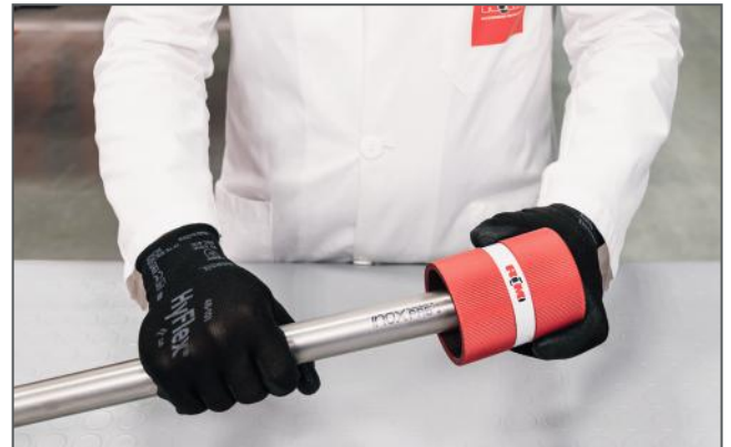
Sbavatura del tubo / Deburring the pipe
