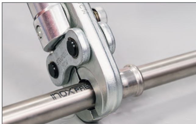
Assemblaggio attraverso pressatura / Making the press connection
