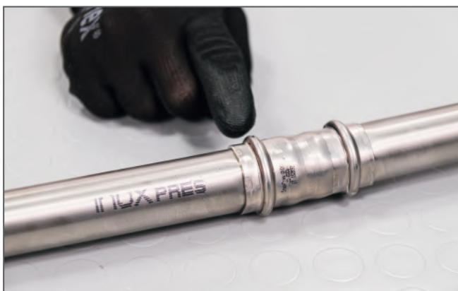
Controllo della pressatura / Checking the press connection
