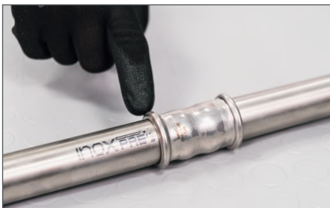
Controllo della pressatura / Checking the press connection
